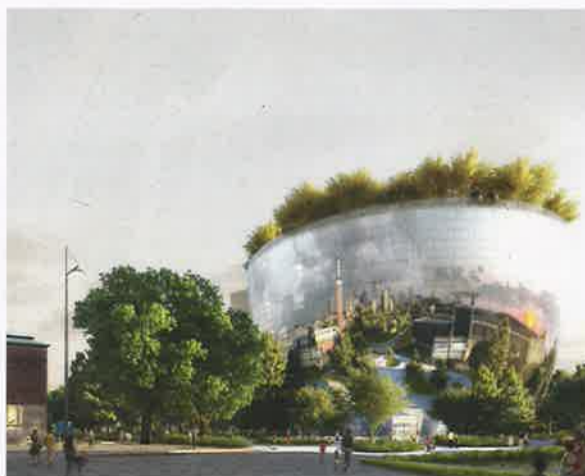
De halve betonnen bol wordt bekleed met spiegellende panelen.
